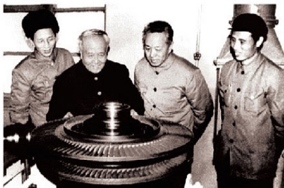
1968年在410厂检察用808合金制作的发动机涡轮盘
